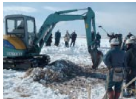
小型バックホーによる地盤掘り下げ作業
