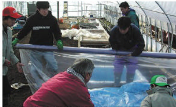
水質浄化実証試験に使用する水槽に水が漏れないようにビニールを張っているところ
