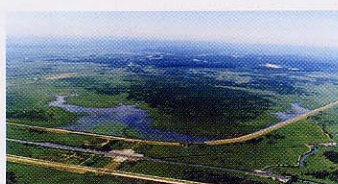
湿水試験地の状況(平成13年10月) 湛水面積:約200ha 湛水水位:標高約2.9m
