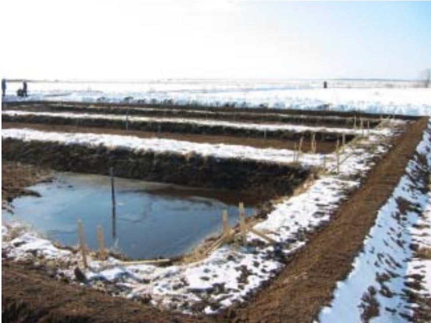
1-1. 表土剥ぎ取り試験区の概観（試験区 3）
