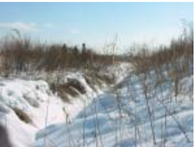
3-4. 明渠堰止め予定箇所
