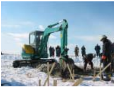
1-3. 小型バックホーによる剥ぎ取り
