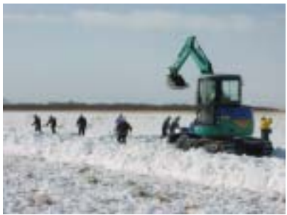
1-2. 人力によるアイスブリッジの施工
